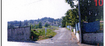
Carrefour entre la RD 1084 et le chemin du Lavoir (projet de giratoire)
