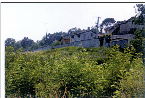
Partie haute du terrain avec une forte pente
