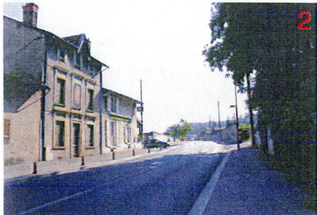
Vue de la RD 1084 en direction du sud-ouest au niveau du carrefour de la limite est du site (giratoire prévu). Bâti en alignement sur rue, mur de séparation de part et d'autre de la RD.
