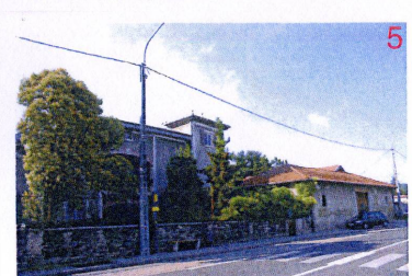
Vue depuis la RD 1084 du seul ensemble bâti du site : maison d'habitation et corps de ferme -> à préserver et valoriser selon un programme restant à définir.
