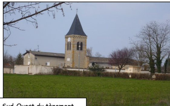
Vues depuis le Sud-Ouest du tènement
