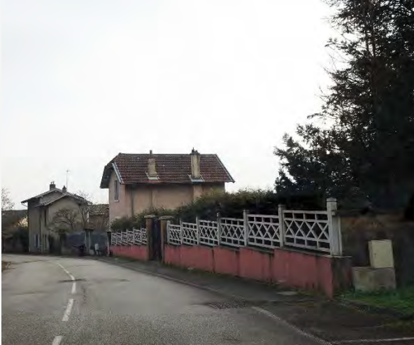
Clôtures béton Montée Neuve
