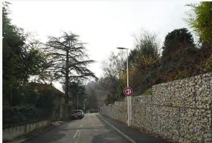
Soutènement Montée neuve
