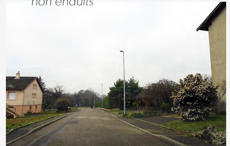
Pas de clôture – Rue de l'Eglise
