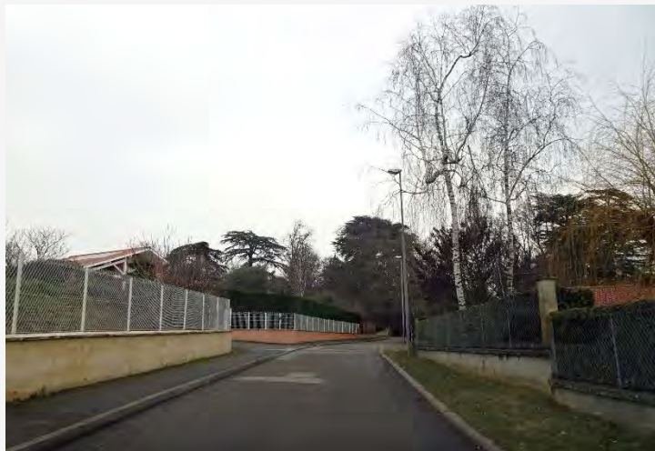
Mur bahut et Grillage
